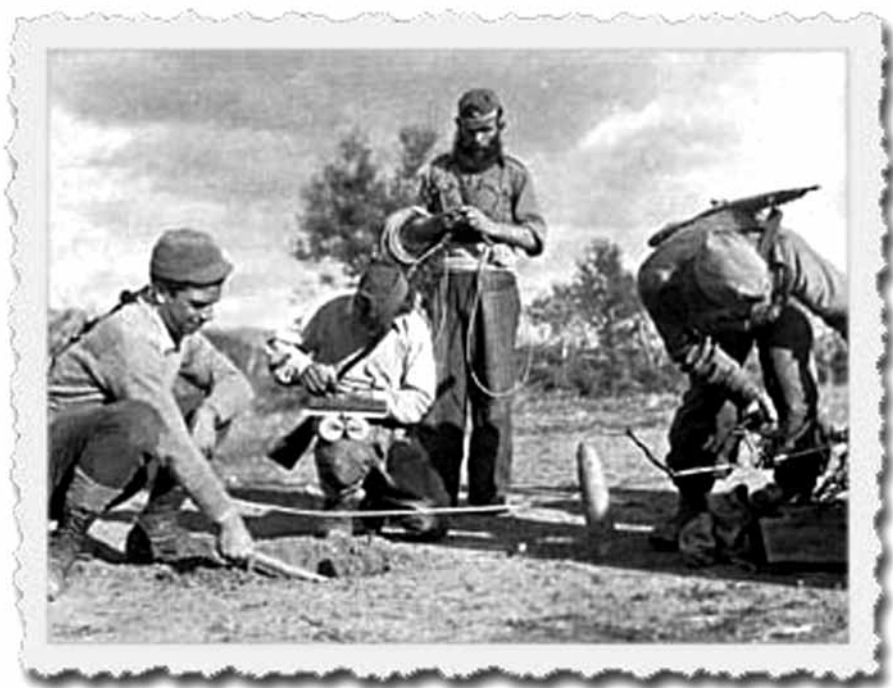
Προετοιμασία για σαμποτάξ στο σιδηρόδρομο
